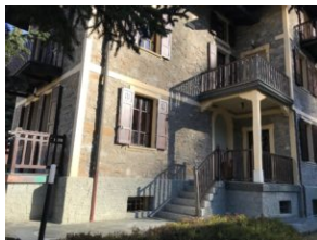
Casa Rovighi a Courmayeur
